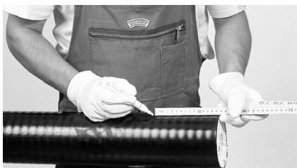
1 Märk ut avstånden (x, y, z) + 1 cm från änden på kulverten.
